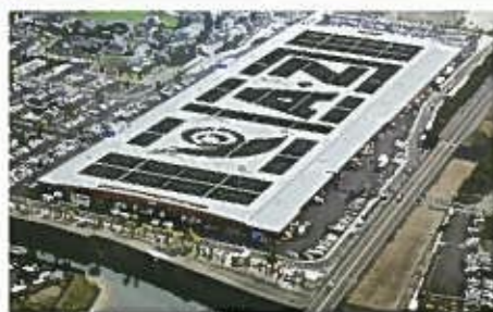
A-Zはやと (1.9MW) / 鹿児島県霧島市・2013年3月完成予定
