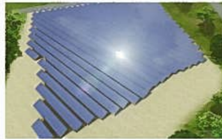
自社メガソーラー (1.9MW) / 長崎県島原市・2013年3月完成予定
